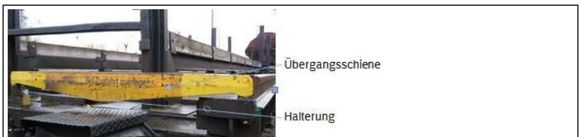
Bild 2: In die Halterung abgelegte Übergangsschiene bei Zugfahrten
