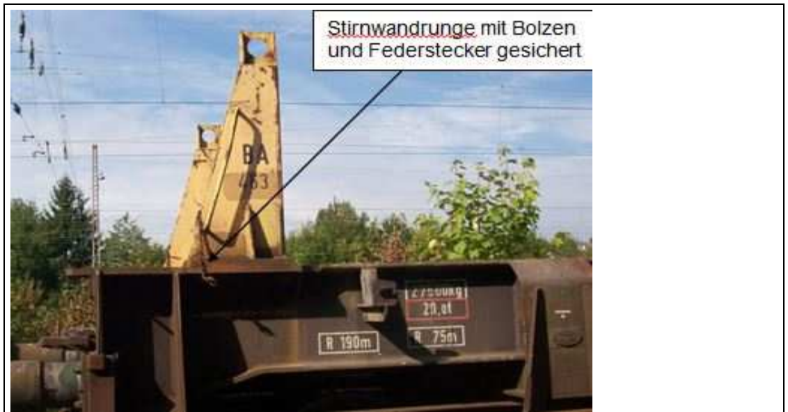
Bild 3: Stirnwandunge durch Bolzen und Federstecker gesichert
