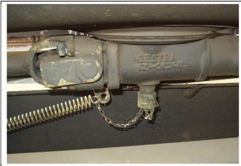
Abb. 36 Notbetätigungsschraube mit aufgesetzter Schutzkappe
